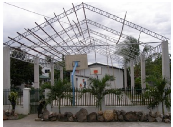
- Afbeelding 8: De bouw is begonnen.
