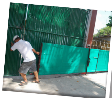
De verrijdbare damwand
