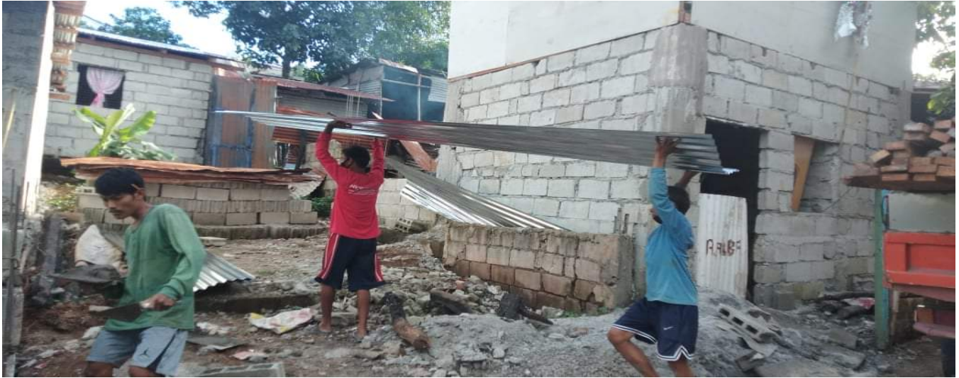
Herbouw woonwijk wat door brand helemaal was weggevaagd.
